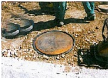
Einsatz einer Eisenplatte
