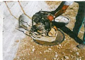
Einrütteln des Teleskops in die Trageschicht
