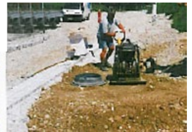
Unterfüllen des Aufsatzstückes und Verdichten
