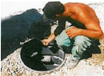
Aufbringen von Gleitmittel auf das Teleskop - Spitzende
