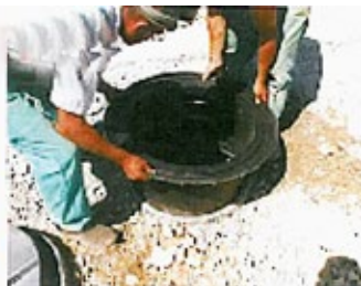
Setzen des Teleskops - Einfahren in die Konus Dichtung
